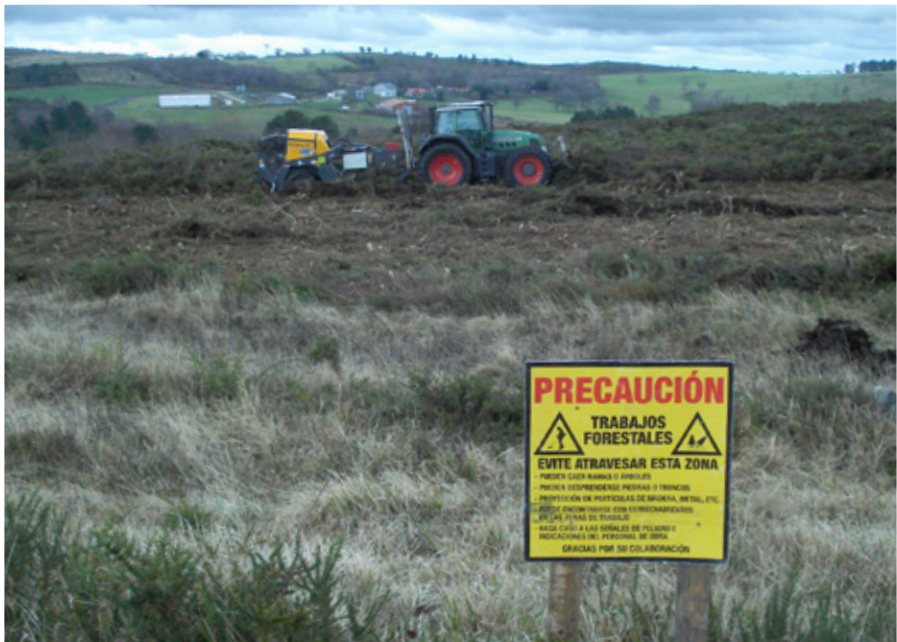
Señalización de obra.
